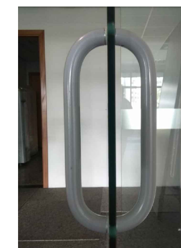
FOTO 4: PUXADOR TUBULAR TIPO "C" (Ø 25mm) EM ALUMÍNIO NA COR CINZA PARA PORTAS EM VIDRO TEMPERADO PIVOTANTES – PADRÃO EXISTENTE A SER SEGUIDO
