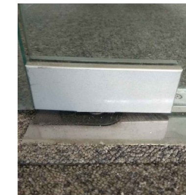
FOTO 5 – REFERÊNCIA: MOLA DE PISO E DOBRADIÇA PARA PORTA DE GIRO PIVOTANTE, PRATA FOSCO – PADRÃO EXISTENTE A SER SEGUIDO.
