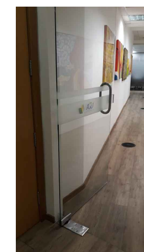
FOTO 3 – REFERÊNCIA: PORTA PIVOTANTE EM VIDRO TEMPERADO EXISTENTE NO 8º ANDAR.
