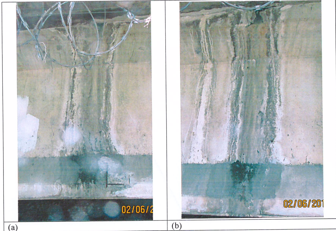
Figura 20: (a) e (b) eflorescência
