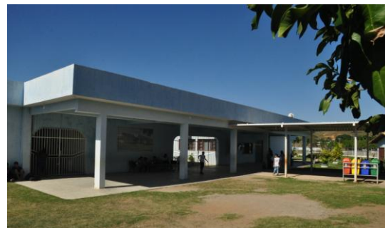
Escola Municipal Casimiro Moreira da Fonseca _Bairro Verdes Campos_
