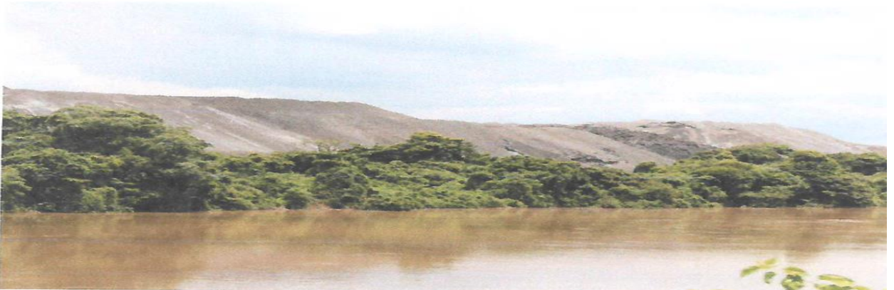
Sinais na pilha de resíduos de deslizamentos e ausência de taludes e estruturas geotécnicas de proteção ou contenção.
