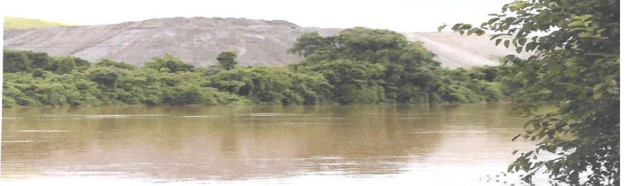
Sinais de trinca e escorregamentos nas laterais da montanha de resíduos, ausência de taludes e estruturas geotécnicas de proteção ou contenção.
