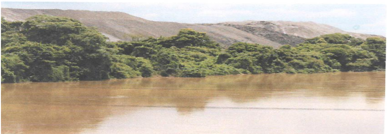
Proximidade da montanha de resíduos da margem do rio Paraíba – volume dos resíduos pode alcançar e interromper o fluxo do Rio Paraíba, gerando uma catástrofe.
