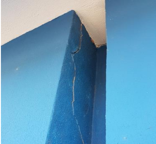
Trincas verticais em decorrência do deslocamento da laje superior
