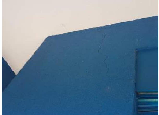
Trincas verticais em decorrência do deslocamento da laje superior
