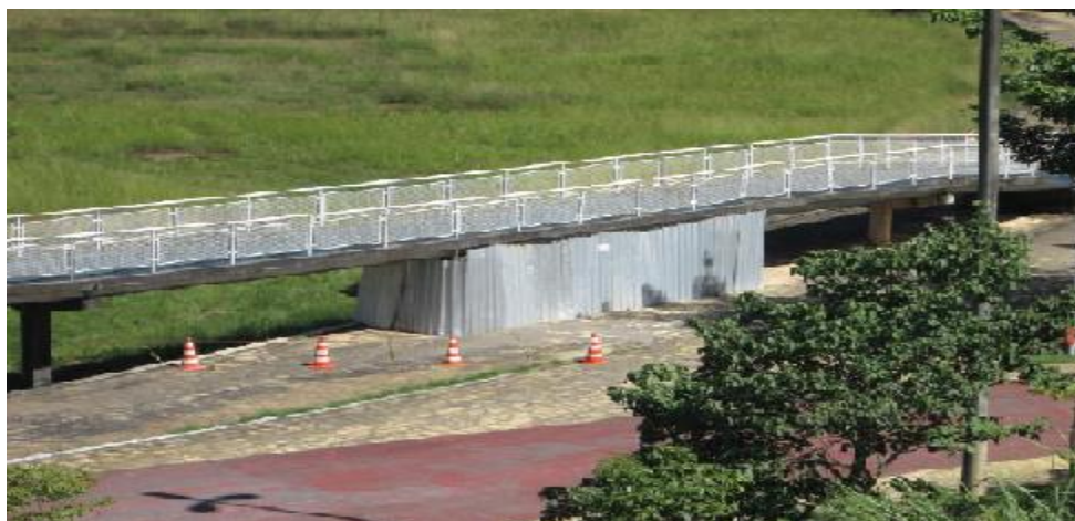
Trecho interditado da passarela
