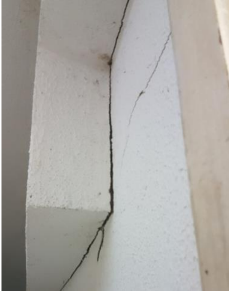
TEATRO: afastamento das estruturas independentes; grave infiltração do teto
