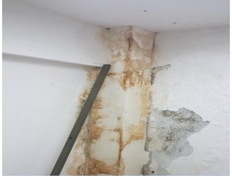
TEATRO: afastamento das estruturas independentes; grave infiltração do teto
