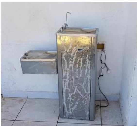
Filtro sem indicação de manutenção
