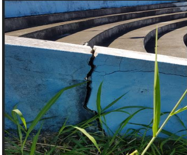
(i) parte do espelho da arquibancada se desprendendo (quadra) (ii) mureta com rachadura (anfiteatro)
