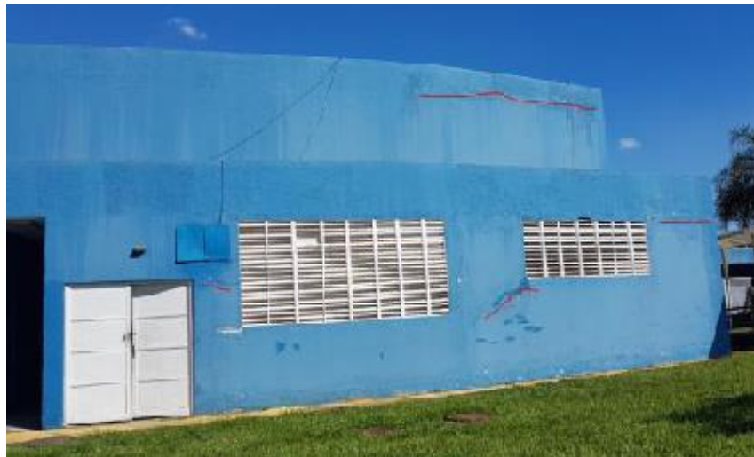
Entrada do refeitório; fachada apresentando trincas
