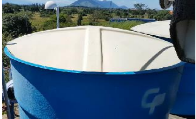
Reservatório com tampa sem o encaixe correto.
