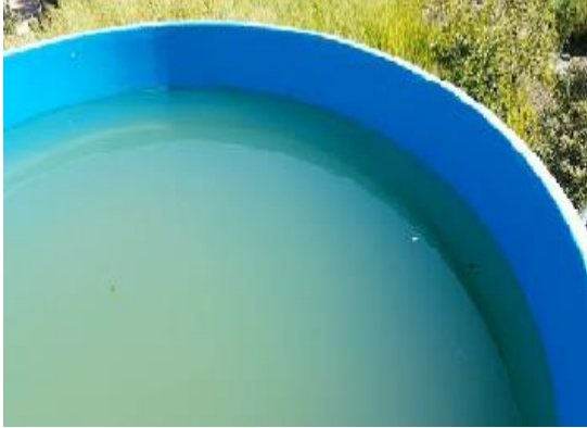
Reservatório sem tampa e com água turva Há risco de contaminação nos reservatórios
