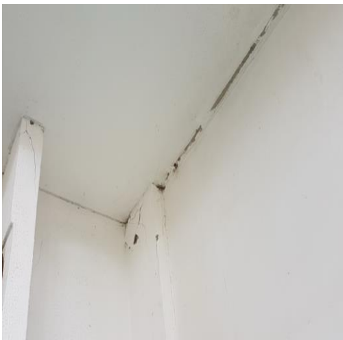
Alvenaria sem aperto na última fiada; ruptura da alvenaria em decorrência do deslocamento da laje superior
