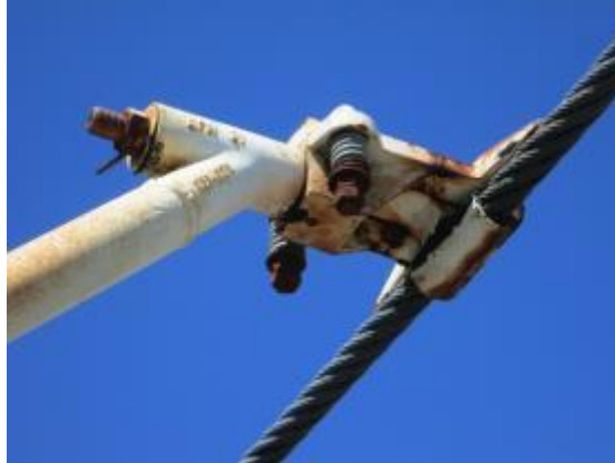
Estado de precariedade das conexões do teleférico
