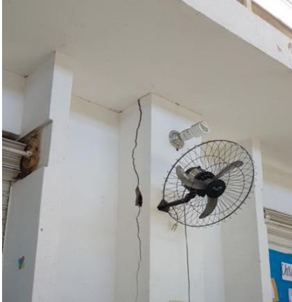
Ruptura da alvenaria em decorrência do deslocamento da laje superior; trincas no piso.
