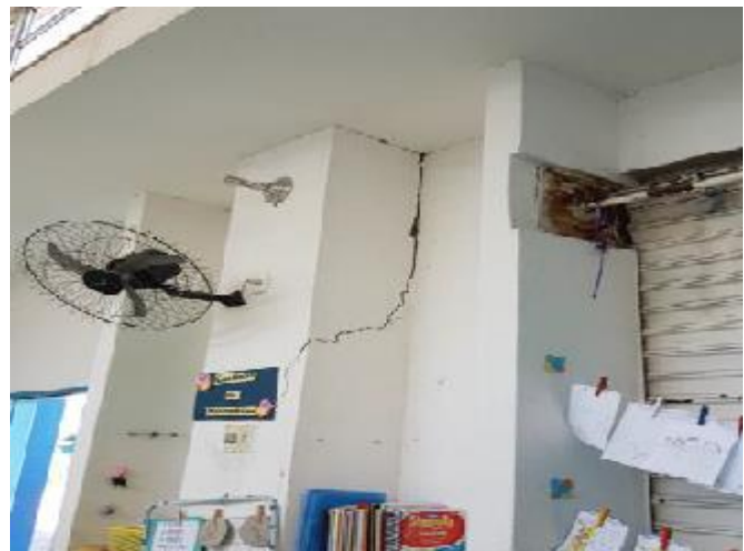
Alvenaria sem aperto na última fiada; ruptura da alvenaria em decorrência do deslocamento da laje superior
