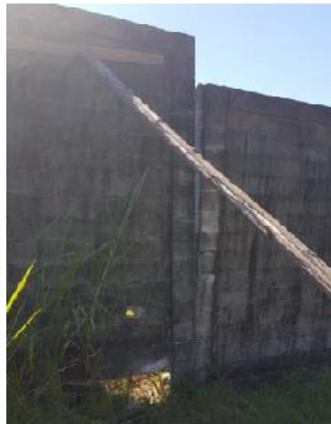
O muro encontra-se danificado, com grande desaprumo. Para o escoramento utilizam-se escoras em madeira
