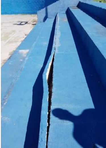
(i) parte do espelho da arquibancada se desprendendo (quadra) (ii) mureta com rachadura (anfiteatro)
