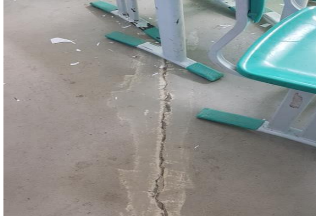
Ruptura da alvenaria em decorrência do deslocamento da laje superior; trincas no piso.
