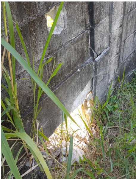
O muro encontra-se danificado, com grande desaprumo. Para o escoramento utilizam-se escoras em madeira
