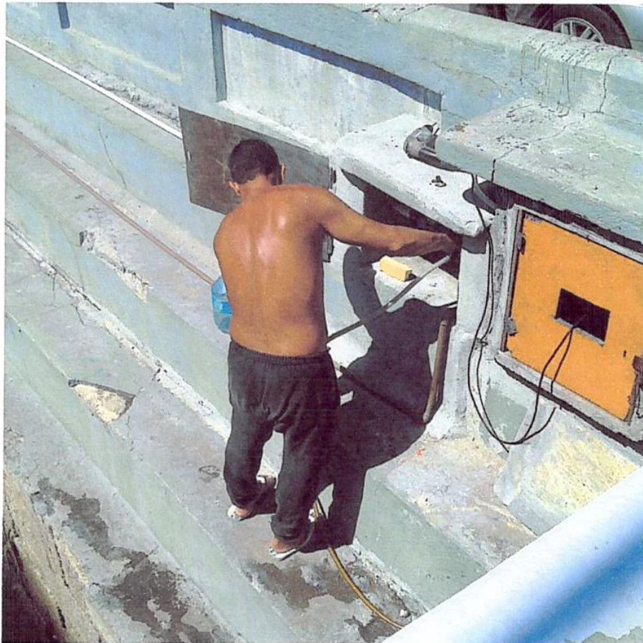
Pescador local fazendo uso de uma dessas caixas de concreto com rede elétrica.
