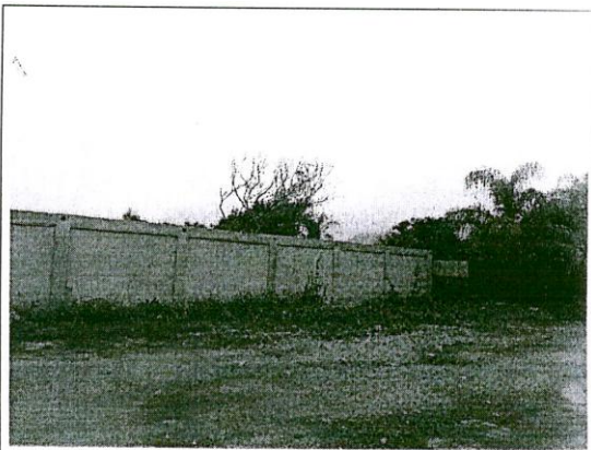
Figura 7 – Testada do local, próximo ao nº 399.
