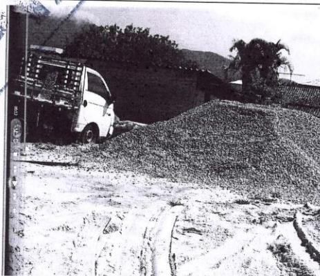
Deposito de brita sem proteção
