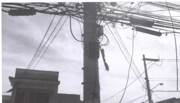
Foto 12 – Avenida da Areia Branca, próximo ao número, 1215, em frente à Galeria Areia Branca
