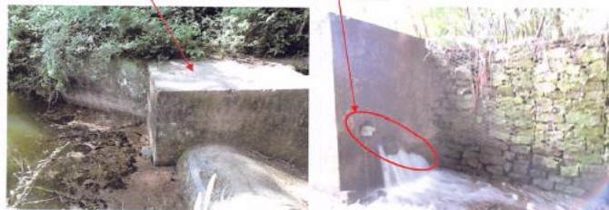
Fotos 3 a 5 – Vistas gerais – Vertedouro e caixa de manobra
