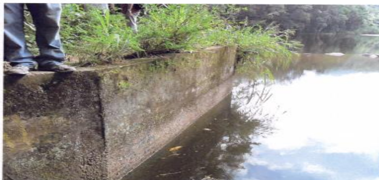
Fotos 8 e 9 - Paredo do vertedouro
