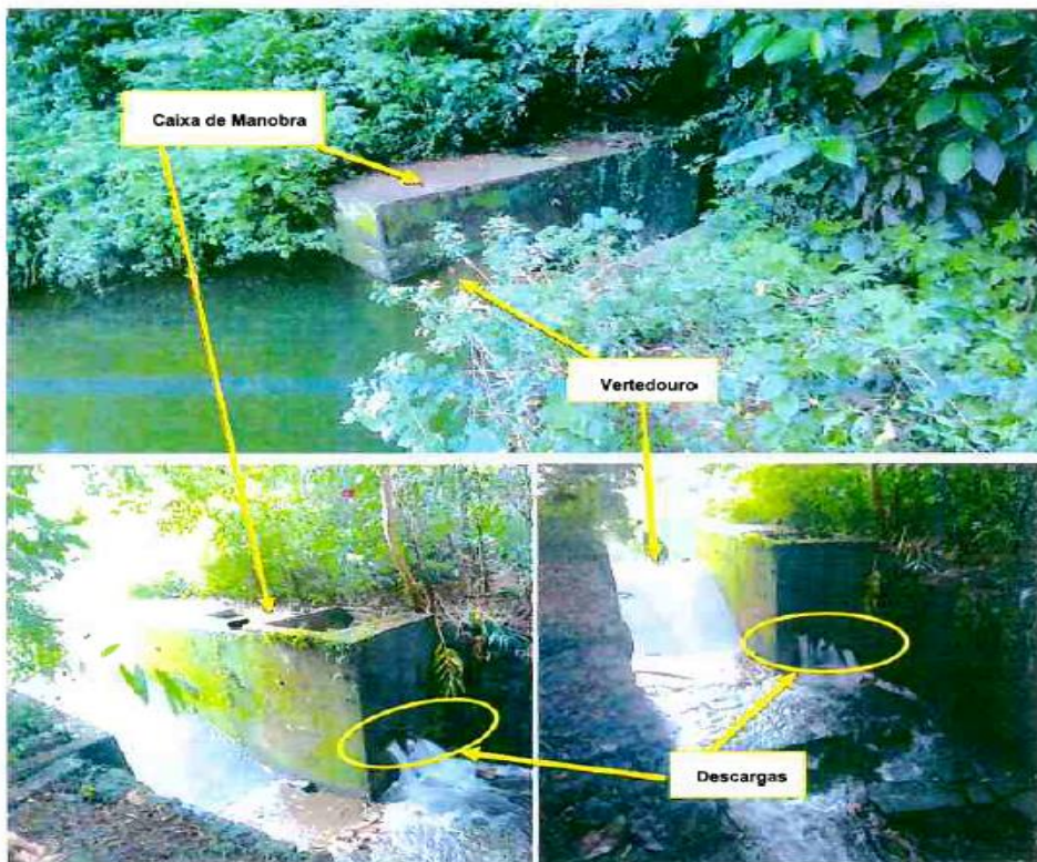
Fotos 2 a 4 – Vistas gerais – Vertedouro, caixa de manobra e descargas.
