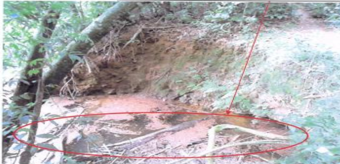
Fotos 12 – Trecho de solo natural que desbarrancou – Montante da barragem
