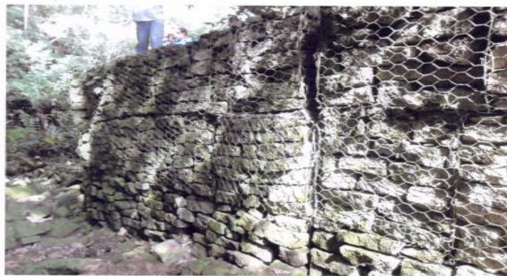
Fotos 10 e 11 – Muros de contenção executados com gabiões
