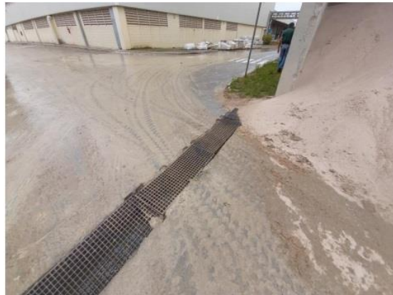
Material estocado sobre a galeria de águas pluviais.
