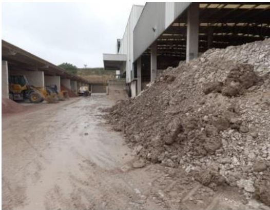
Pátio entre as baias sem qualquer controle de contenção.
