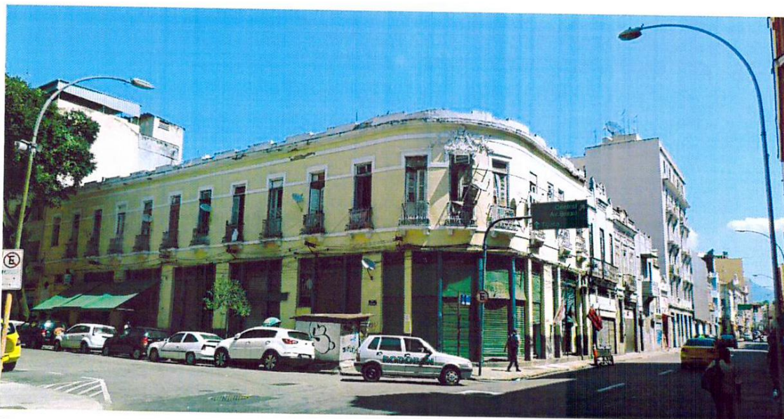
Figura 24: Vista geral da fachada do imóvel.
