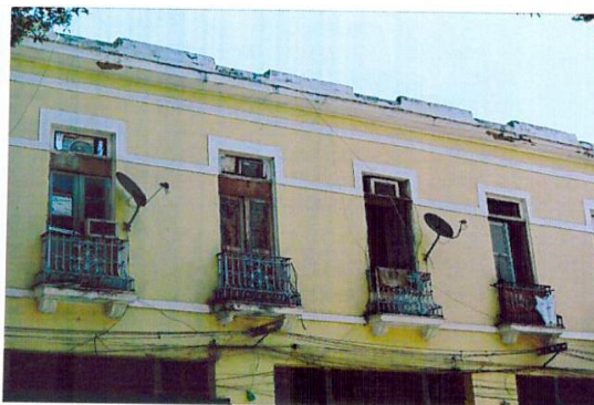
Figura 23: Vista da fachada da Rua Ubaldino do Amaral. Observam-se aparelhos de ar condicionado e antenas fixados na fachada.
