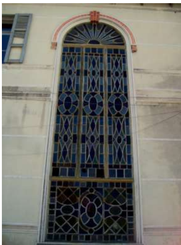
Figura 3: Detalhe do vitral que ocupa os dois pavimentos do imóvel.
