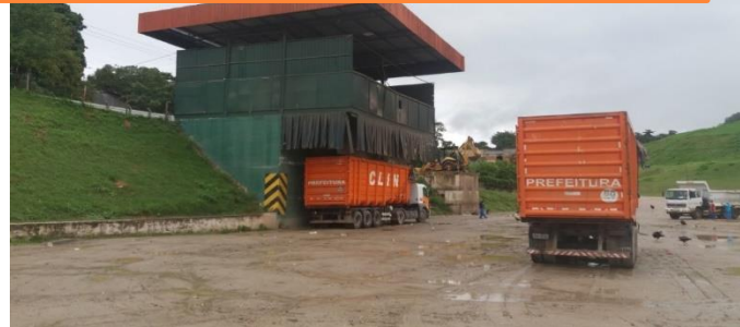
Estação de Transbordo – Morro do Céu
