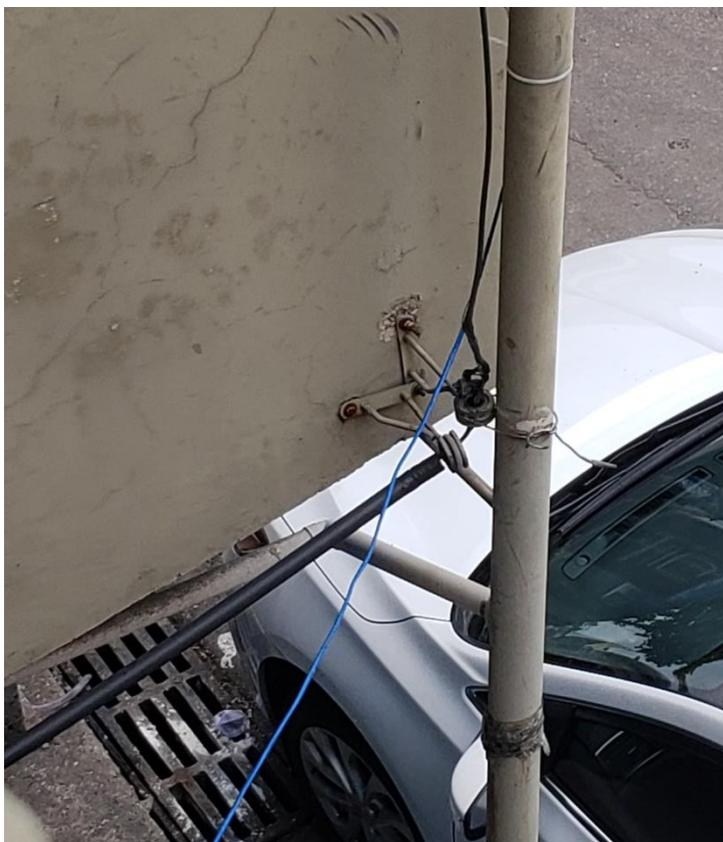
**Figura 22** – Tubulação hidráulica afixada no SPDA.
