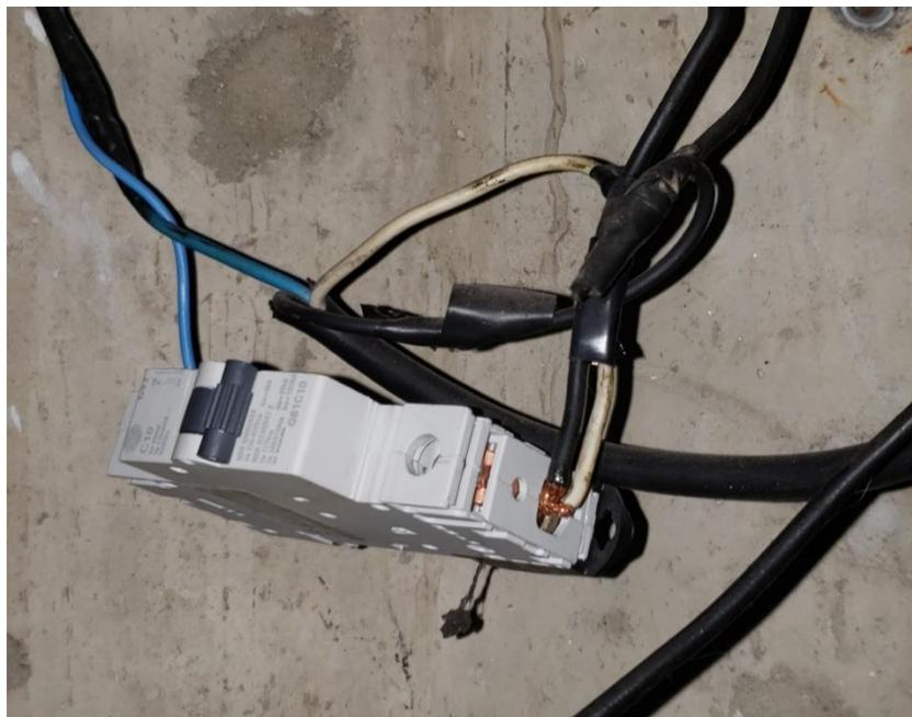
**Figura 3** – Detalhe do disjuntor pendurado, com condutores acessíveis.
