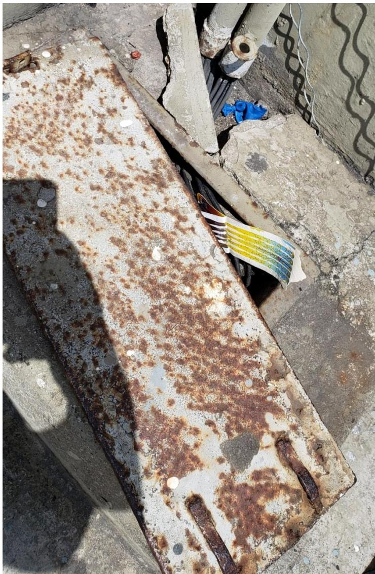
**Figura 13** – Caixa de passagem do sistema de iluminação com fechamento inócuo, permitindo acesso do público.
