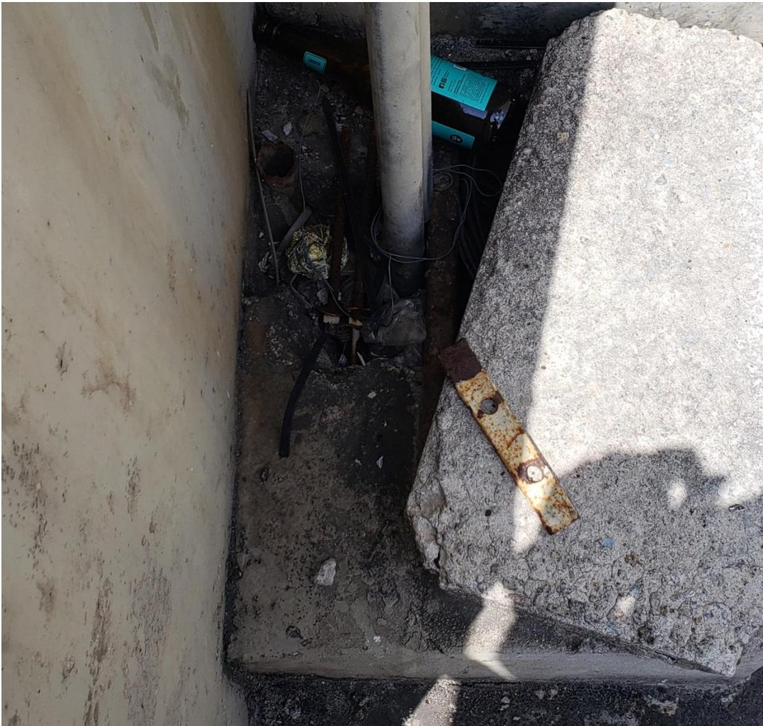
**Figura 18** – Caixa de passagem do sistema de iluminação com tampa improvisada de concreto, que não impede o acesso aos condutores.
