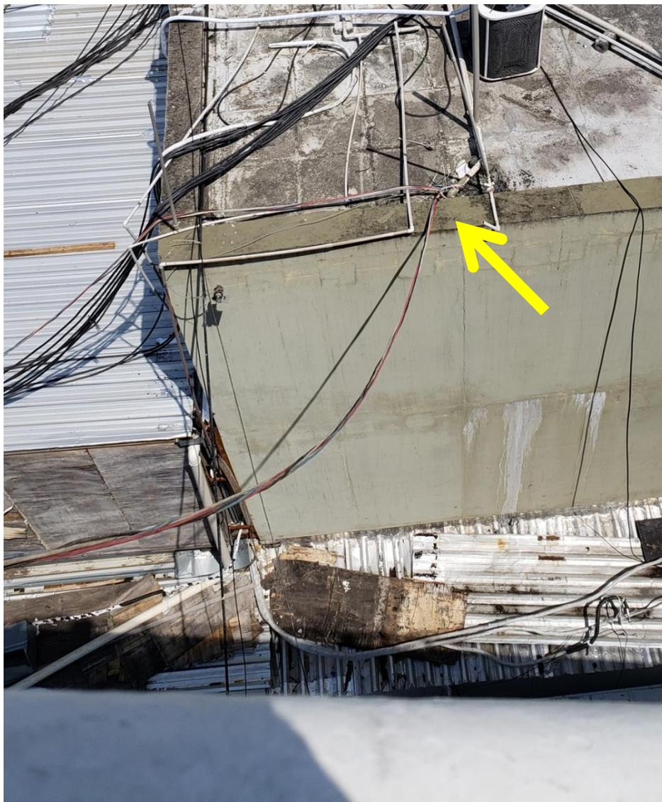
**Figura 14** – Cabeamento de alimentação do telão ancorado em tubulação hidráulica.
