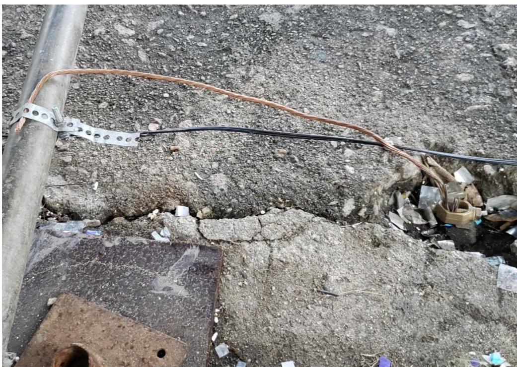
**Figura 9** – Sistema de aterramento com folgas nos contatos elétricos, minando a sua eficácia.
