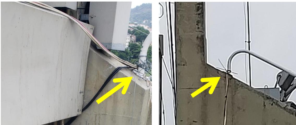
**Figuras 6-a e 6-b** – Cabeamento de alimentação do telão ancorado a) no parapeito do Setor 3, e b) no parapeito do Setor 5
