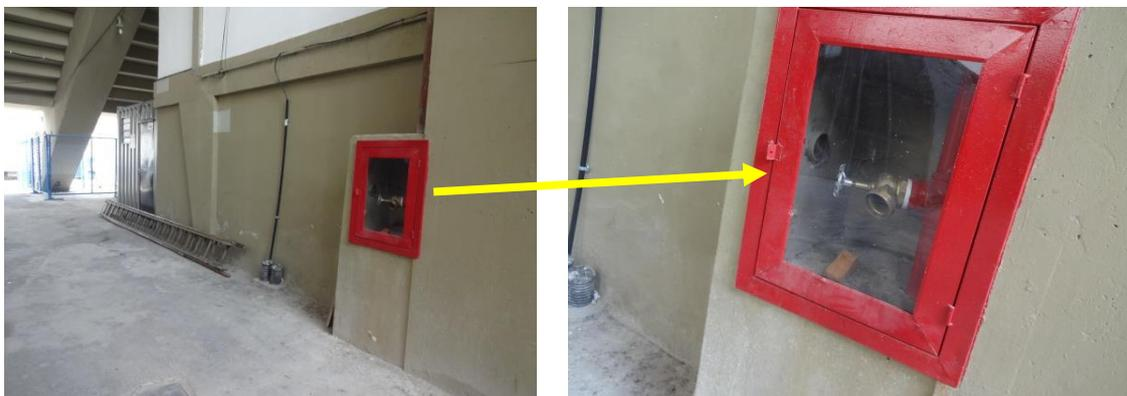
**Figuras 26-a e 26-b – Hidrante no Pav. Térreo do Setor 12**
