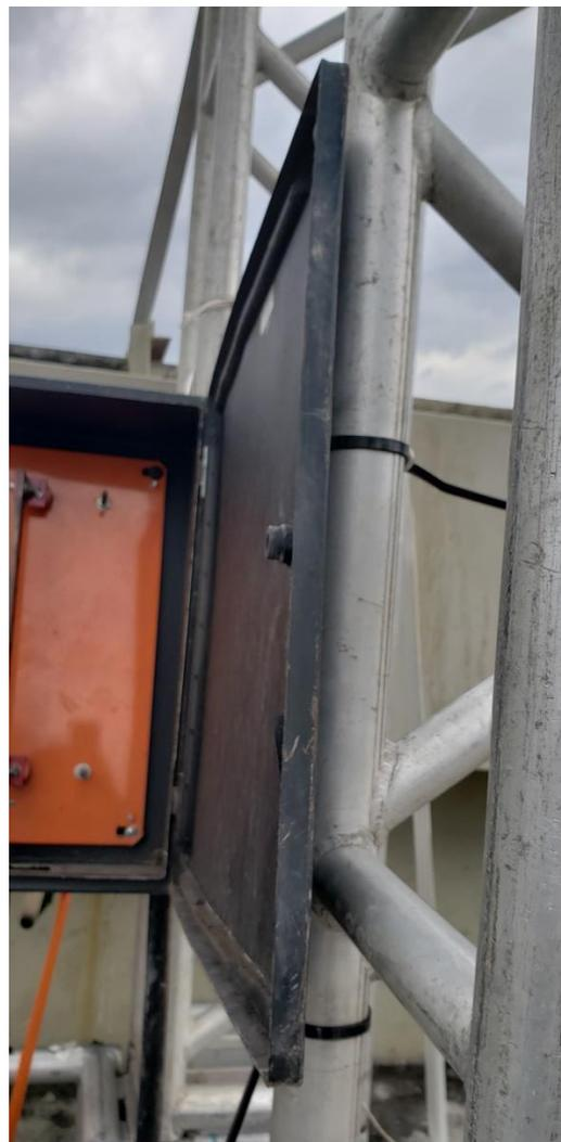
**Figuras 5-a e 5-b** – Quadro do barramento do telão: condutores de uma das fases e do terra na mesma cor, e não há dispositivo de fechamento no quadro.
