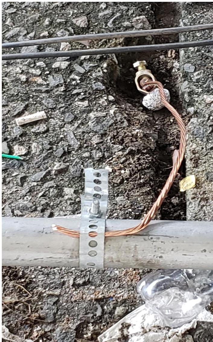
**Figura 21** – Dispositivo para aterramento da estrutura da área das cadeiras improvisado.
