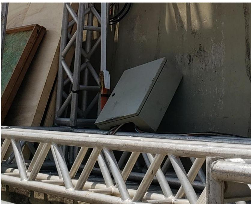
**Figura 12** – O quadro do barramento do telão não está fixado.
