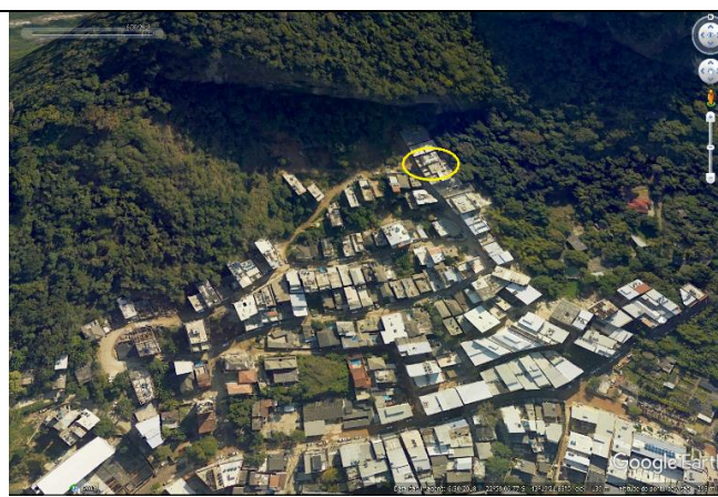
30 de junho de 2018 – Google Earth Prédios que desabaram circulosados.
