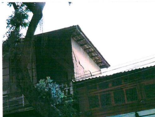
**Figura 09:** Detalhe do beiral deteriorado e do desprendimento de alvenaria do imóvel integrante à quadra 13B.
