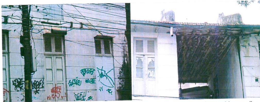
Figura 17: Vedação de janelas nos imóveis e pichações na fachada. Figura 18: Forro em estado precário e calha improvisada.
