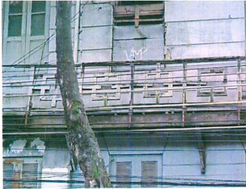
**Figura 06:** Detalhe do guarda-corpo da varanda do imóvel.
