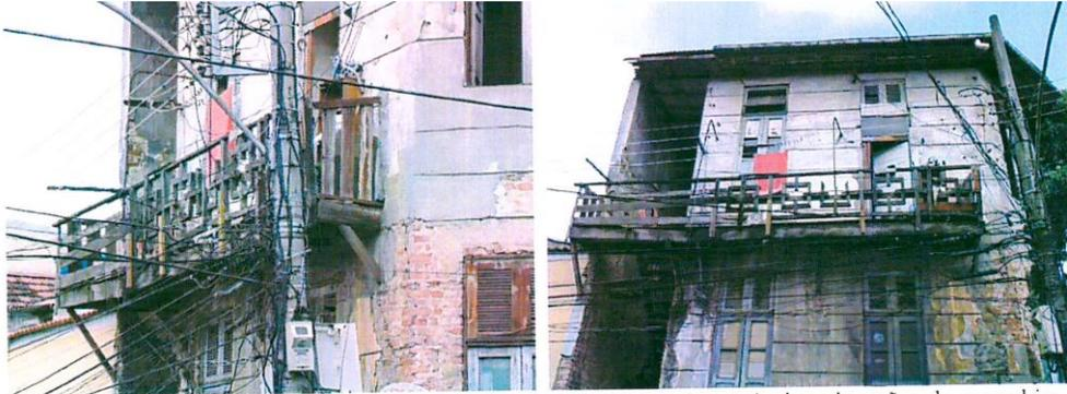
Figuras 61 e 62: Varanda em estado precário, instalações elétricas improvisadas, alterações de esquadrias, desprendimento de revestimento, forro deteriorado.
