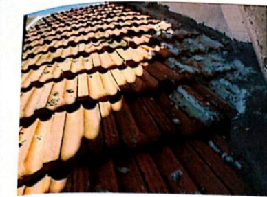
Figuras 07 e 08: Argamassa de cimento colocada de maneira improvisada no encontro entre a alvenaria e o telhado e também no espigão do telhado.
