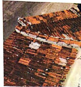
Figuras 07 e 08: Argamassa de cimento colocada de maneira improvisada no encontro entre a alvenaria e o telhado e também no espigão do telhado.
