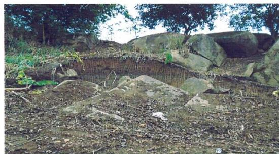
**Figura 13 –** Vista de lotes com vegetação suprimida deixando o solo exposto e retirando blocos de rocha no sopé do talude.
