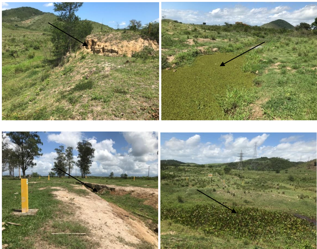
Figura 02: Trechos do traçado do emissário já implantado. Observam-se início de processos erosivos, corpos hídricos assoreados e em processo de eutrofização.
