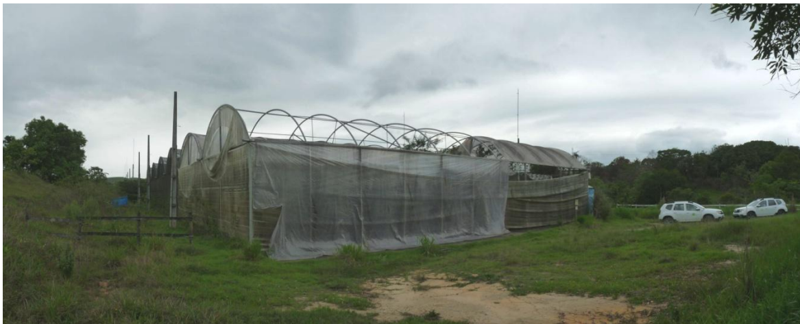
Figura 9: Vista da área externa do viveiro de mudas abandonado na área do COMPERJ.
