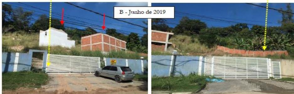
Figura 11 A e B – Porção leste do terreno com muro azul. Verifica-se, na imagem de 2016, o início das intervenções para implantação das vias, que envolveram terraplanagem e corte no relevo e, na imagem de 2019, o muro azul com portão, as vias implantadas, e novas construções (setas vermelhas). Na imagem de 2016 se observa o carregamento de sedimento do interior do empreendimento acumulado na calçada.
