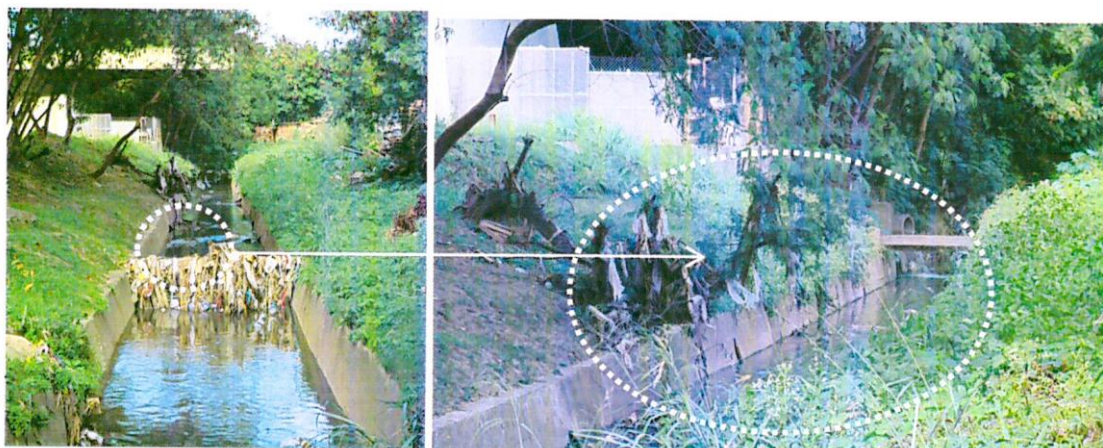
Figura 07: Rio dos Cachorros junto à área da CEASA, com a presença de Ecobarreira sem manutenção.
