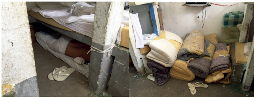
Interno dormindo sob a comarca. Colchonetes guardados ao longo do dia. (inspeção 02.02.17)
