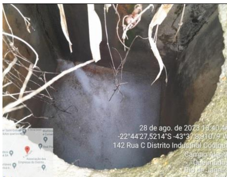
Figura 3. GAP da empresa BURN com identificação de espuma.
