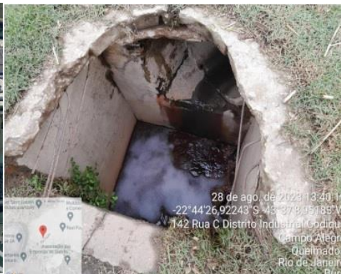
Figura 2. GAP da empresa BURN com identificação de espuma.
