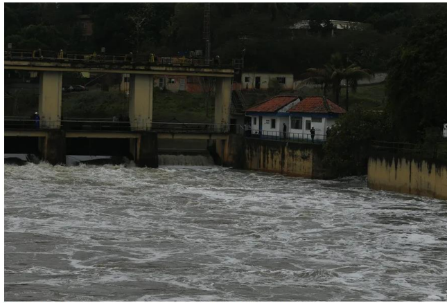
A espuma na água da Estação de Tratamento do Guandu — Foto: Fabiano Rocha / Agência O Globo
