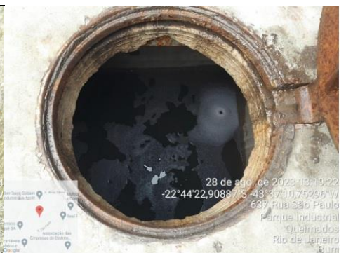
Figura 4. GAP da empresa BURN com identificação de espuma.
