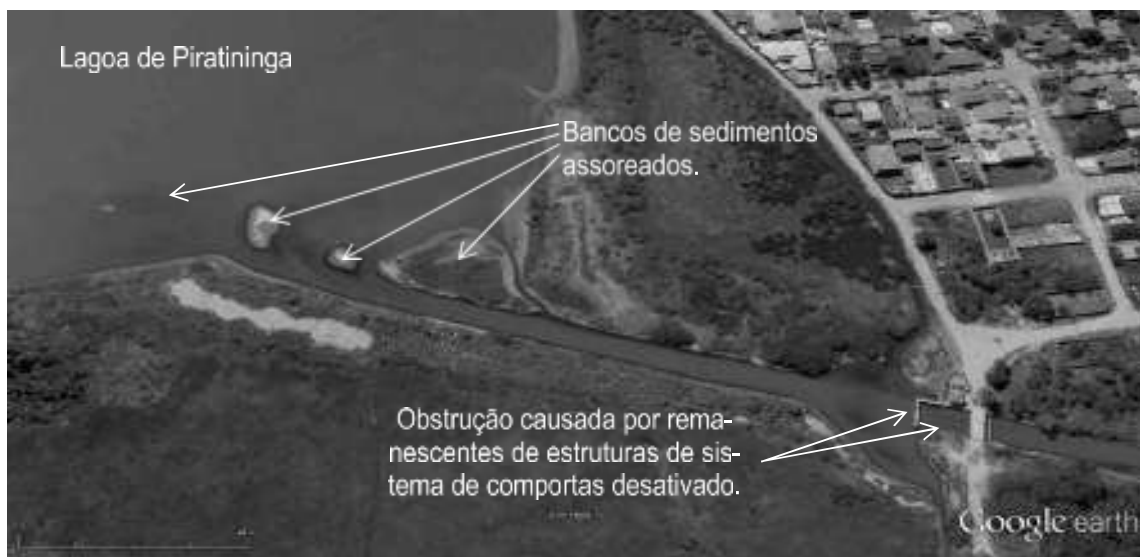
FIGURA 4. IMAGEM MOSTRANDO A LIGAÇÃO DA LAGOA DE PIRATININGA COM O CANAL DE CAMBOATÁ, COM INDICAÇÃO DE OBSTRUÇÃO CAUSADA POR REMANESCENTES DE ESTRUTURAS DE SISTEMA DE COMPORTAS DESATIVADO E DANIFICADO
