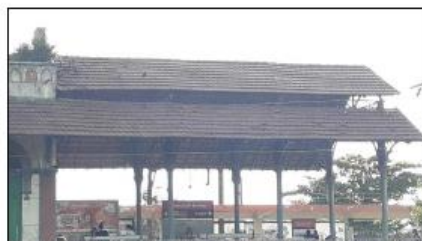
Detalhe de trechos do telhado que cobre a plataforma voltada para a Rua João Vicente, com telhas faltantes e deslocadas.
