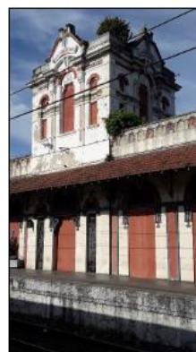
Detalhe da parte superior da estação, apresentando pequenos arbustos, que podem vir a comprometer a integridade da fachada voltada para a linha férrea.
