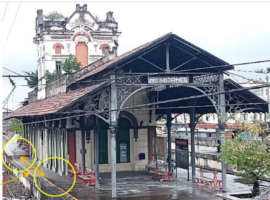
Figura 11 – Vista lateral da estação, tomada do acesso à bilheteria, observando-se a estrutura em ferro fundido. Nota-se, em destaque, a existência de desníveis na plataforma da linha (dois degraus em um lado, e rampa em outro), em razão do alteamento da plataforma realizado em um dado momento, criando assim um rebaixo junto à antiga estação, como forma de manter a fachada e o acesso às portas.
