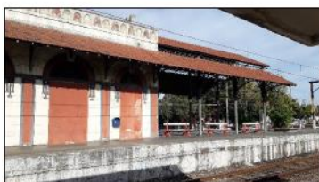
Vista da fachada voltada para a linha férrea, apresentando desgaste dos seus revestimentos.
