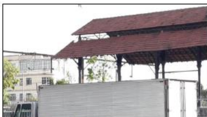
Detalhe de trechos do telhado que cobre a plataforma voltada para a Rua João Vicente, com telhas faltantes e deslocadas.
