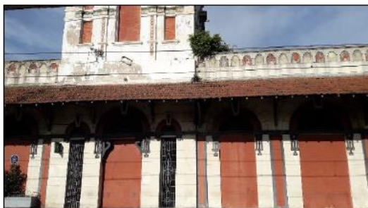
Detalhe da parte superior da estação, apresentando pequenos arbustos, que podem vir a comprometer a integridade da fachada voltada para a linha férrea.
