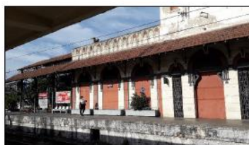
Vista da fachada voltada para a linha férrea, apresentando desgaste dos seus revestimentos.
