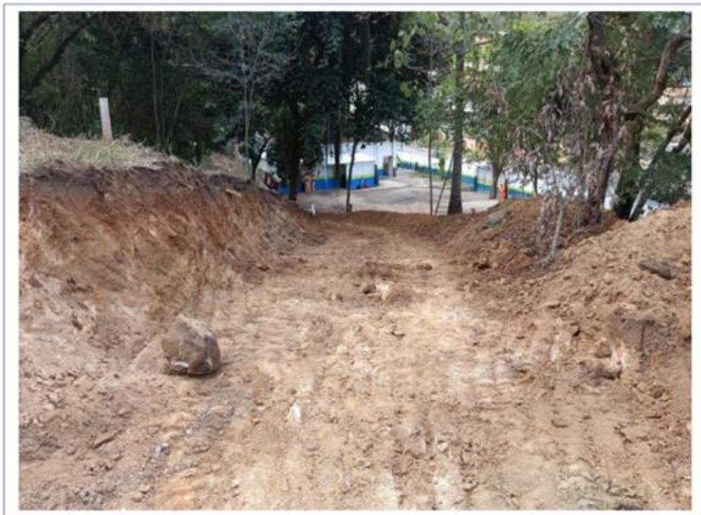
Foto 45 – Escavação do morro para emboque túnel Luís Bom – Emboque Sul
