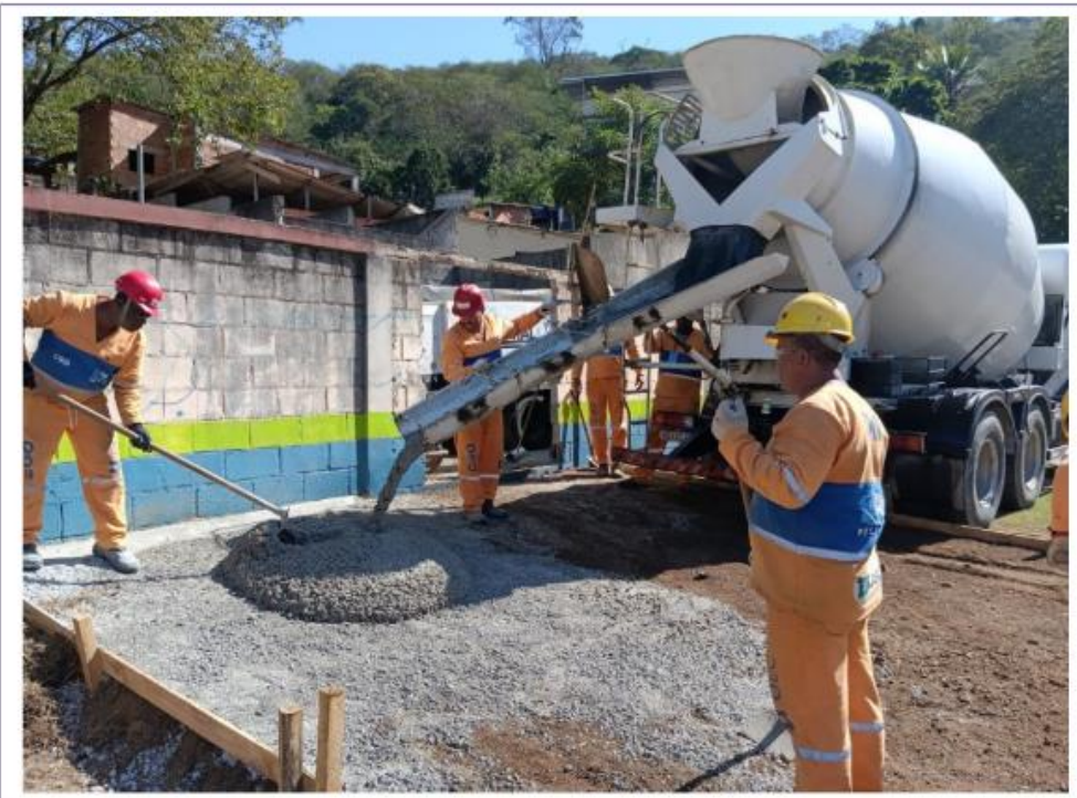
Foto 47 – Rampa de acesso – Emboque Sul
