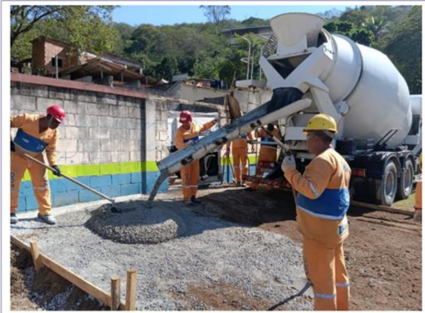
Foto 47 – Rampa de acesso – Emboque Sul
