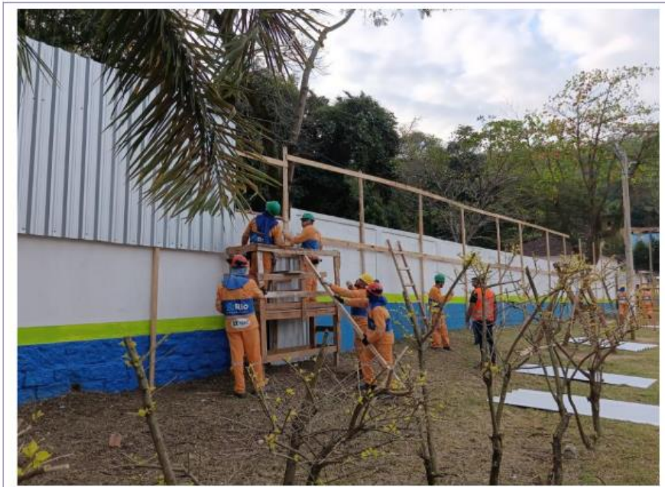
Foto 49 – Tapume fachada canteiro – Emboque Sul
