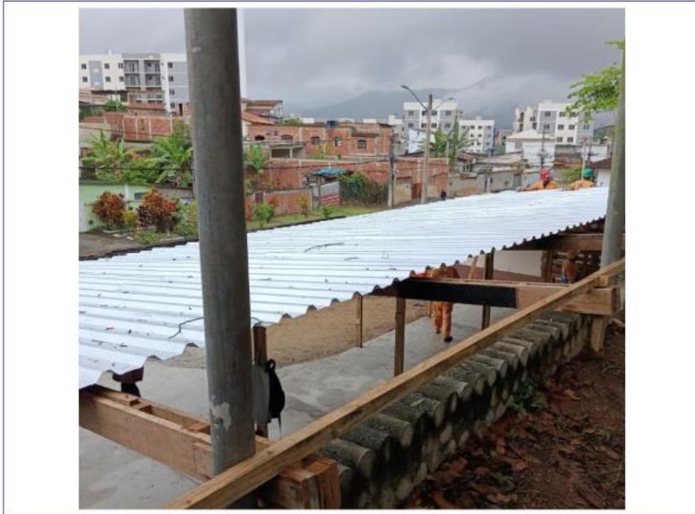
Foto 46 – Área de vivência canteiro – Emboque Sul
