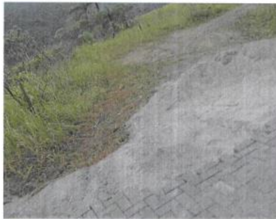
Figura nº 2 – Ponto final do calçamento em 29 de julho de 2020, com expansão de aproximadamente 130 m após a autuação, não obedecendo a paralisação da obra determinada.
