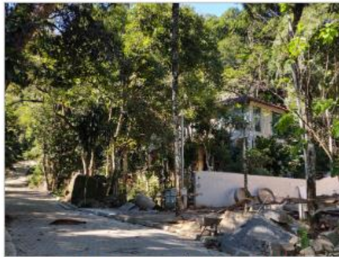
Foto 4: Casa em construção no interior da área.
