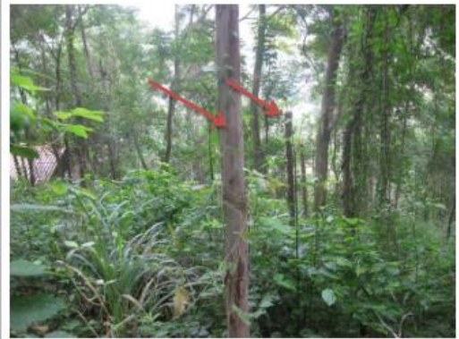
Foto 7: Instalação de mourões.
