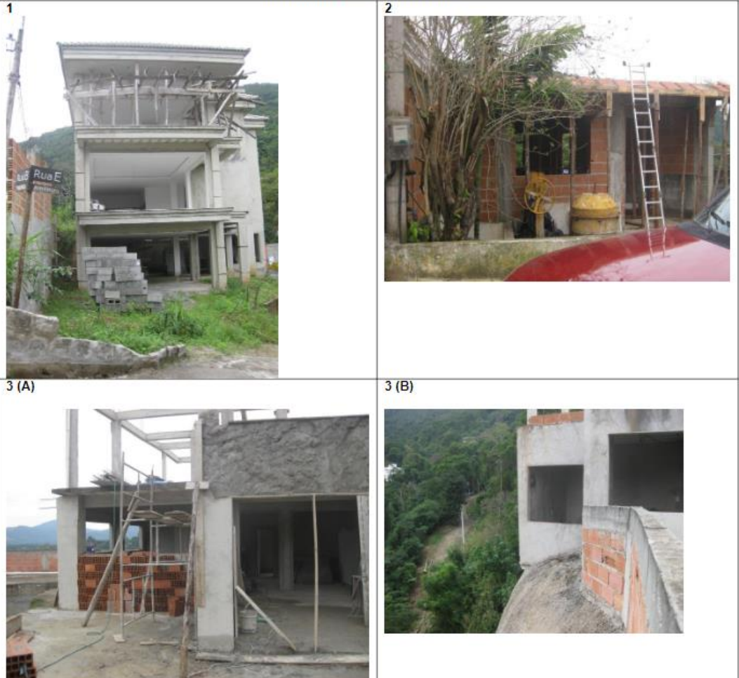
Fotos 1, 2, 3: Casas em construção no condomínio Pedra Bonita. Fotos 3 A e B: Casa construída sobre afloramento rochoso.
