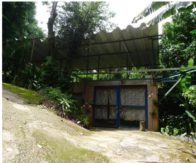
Figura 4: Residência construída entre os Lotes 13 e 15 (não foi possível identificar corretamente o número na ocasião da vistoria)
