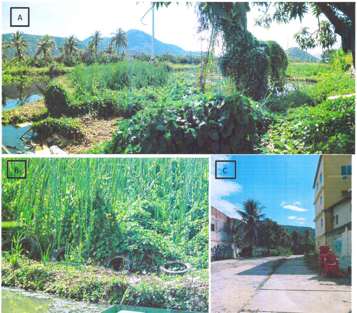
Figura 5: Ilustração de área assoreada (A) nos fundos do terreno (C), ex-pracinha comunitária, localizado na Av. Célia Ribeiro Mendes de Moraes, em frente à rua César Morani (para a direita, início do referido bairro Pantanal); presença de lixo e assoreamento (B).
