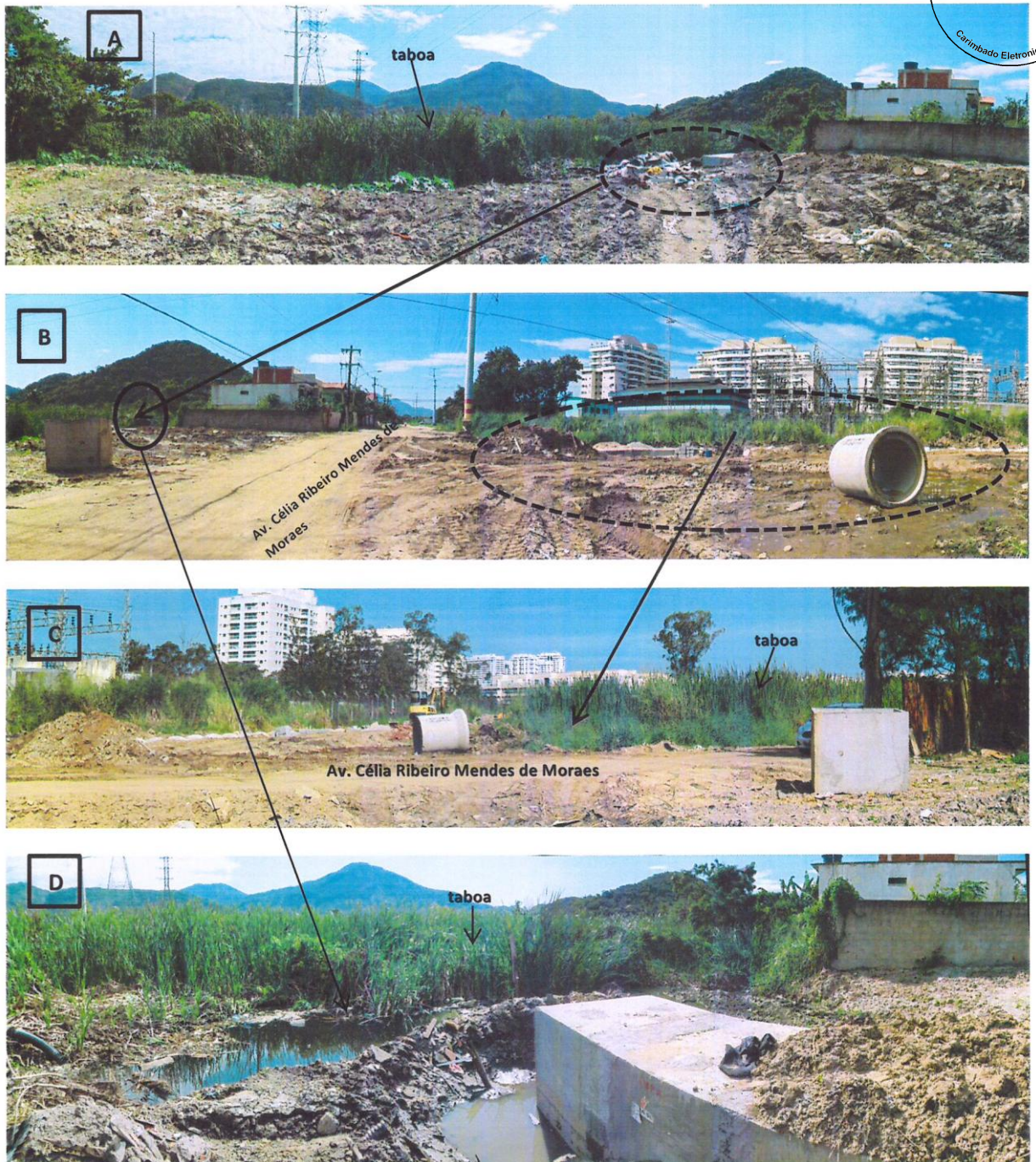
Figura 8: Ilustração do processo de aterramento de área de brejo (APP), observado na Av. Célia Ribeiro Mendes de Moraes, em área próxima à Av. Salvador Allende (localidade denominada bairro Pantanal). Foi observado um processo de manilhamento, porém, sem placa indicativa de obra. Pode ser observado, em "C", que a área de taboa foi seccionada pela via.
