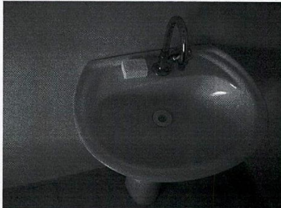
LAVABO CONSULTÓRIO SEM SABÃO LIQUIDO E PAPEL TOALHA
