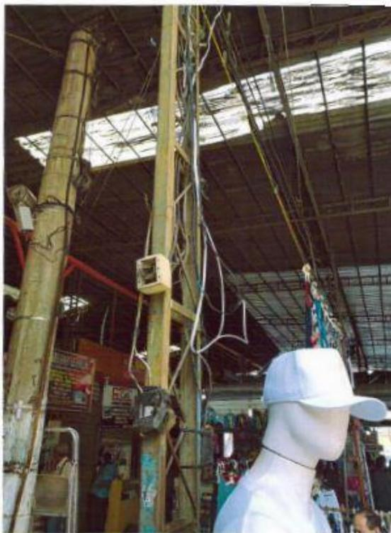
Figura 38: Bloco C, disjuntores fixados no pilar metálico com cabeamento entrelaçado com o mesmo
