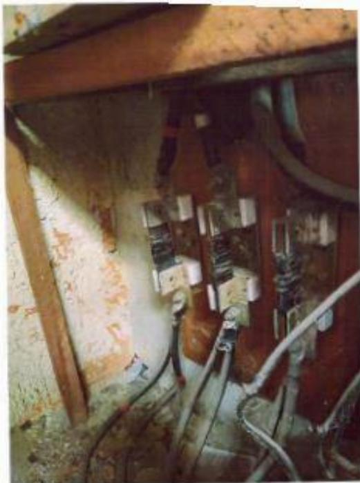
Figura 42: Bloco C, Associação de Favelas, há risco de sobrecarga
