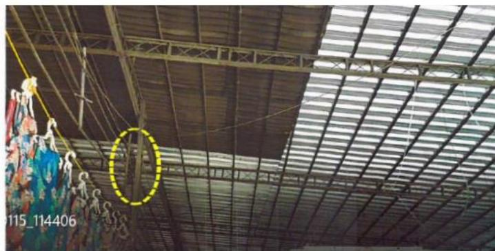
Figura 5: observa-se a sistema estrutural, padrão utilizado, e a trocas de telhas por telhas de aço galvanizado trapezoidais. Ressalta-se a proximidade de condutores de baixa tensão com a estrutura metálica.
