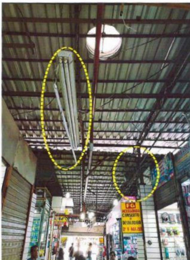
Figura 40: Bloco C, lâmpada pendurada e circuitos expostos
