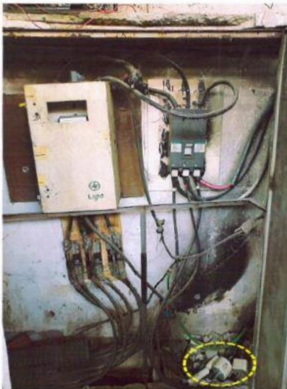
Figura 43: Bloco D, Ausência de fusíveis, há risco de sobrecarga. Evidências de incêndio progressivo e fusíveis, provavelmente inutilizados, retirados
