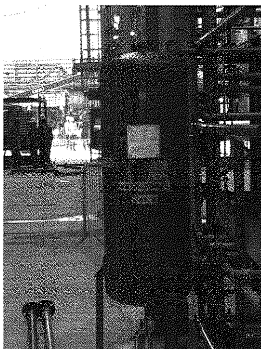
Figura 20 e 21 – Escada e plataformas para inspeções nos vasos de pressão
