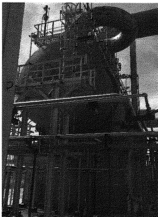
Figura 27- Escada e plataforma de acesso aos bocais para inspeção
