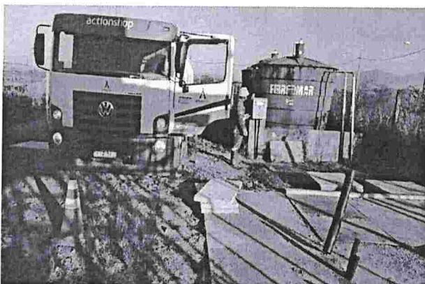
Foto 03: Sucção da caixa estanque do Canteiro da CPL.
