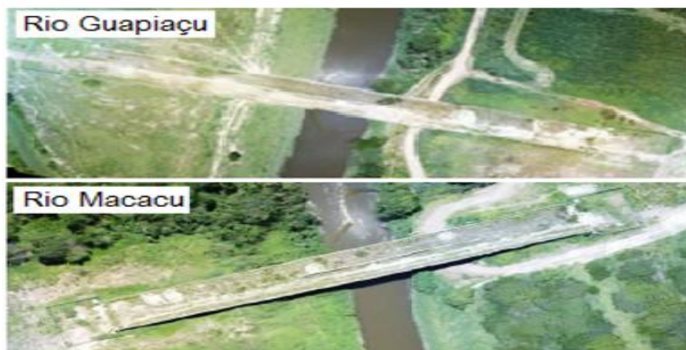
Figura 3 - Imagem aérea das pontes sobre os rios Guapiaçu e Macacu com vista das cercas nas extremidades das pontes contidas no processo E-07/510.020/2012.
