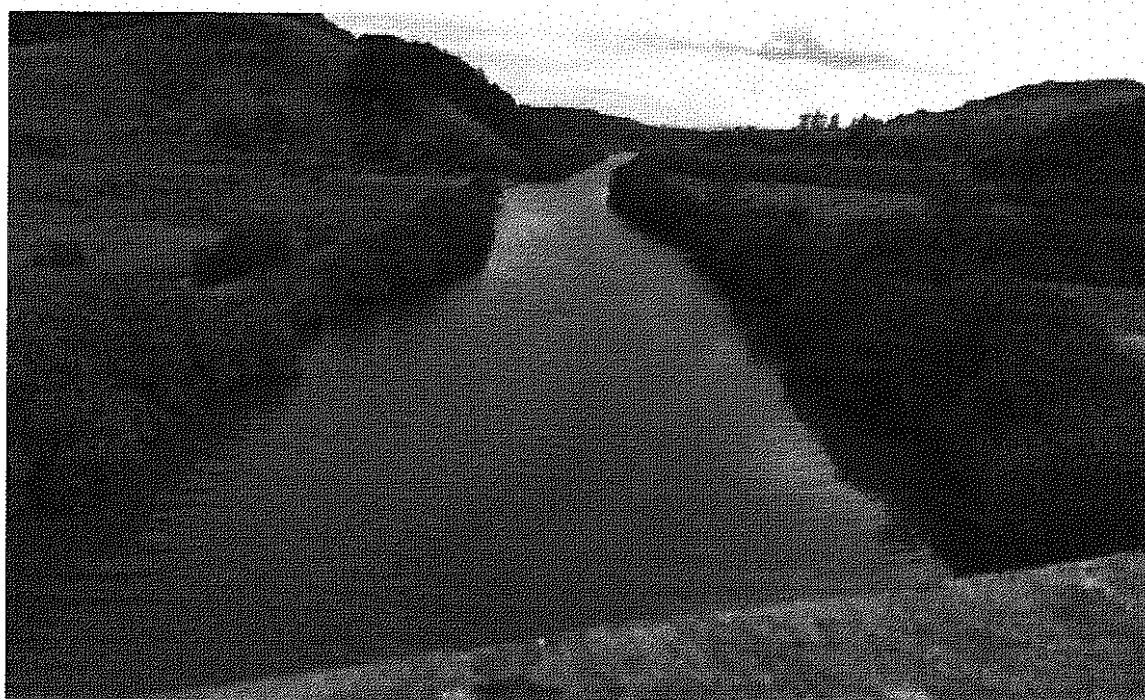
Foto IV-5: Margens à jusante
