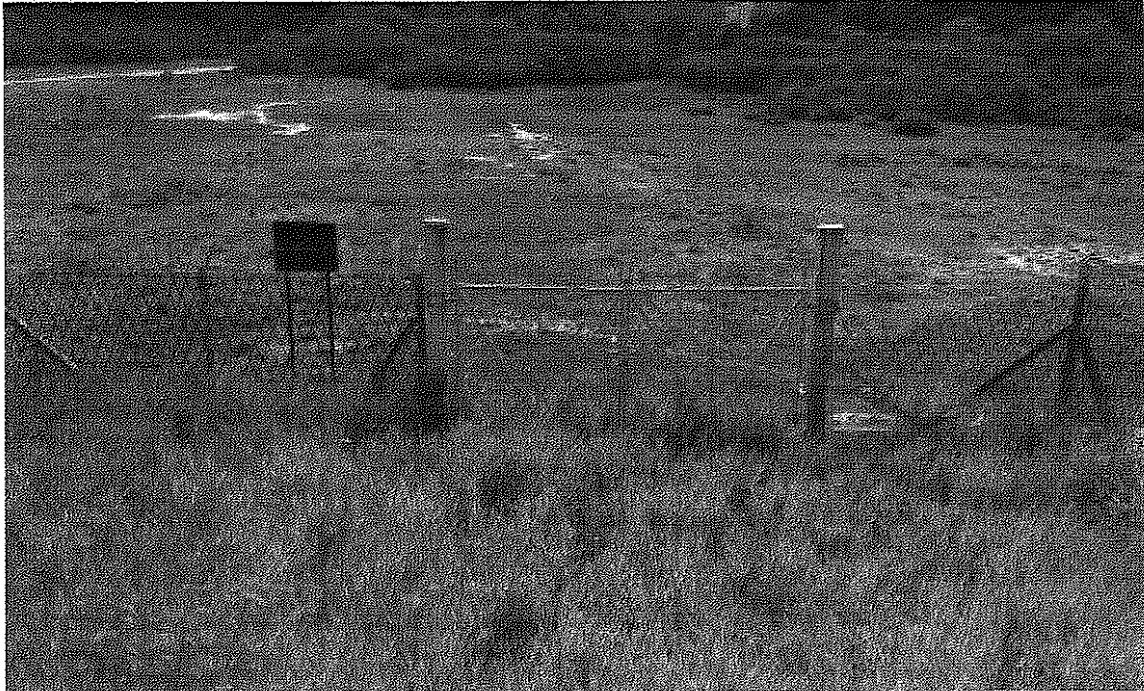
Foto IV-2: Portão de acesso 2
