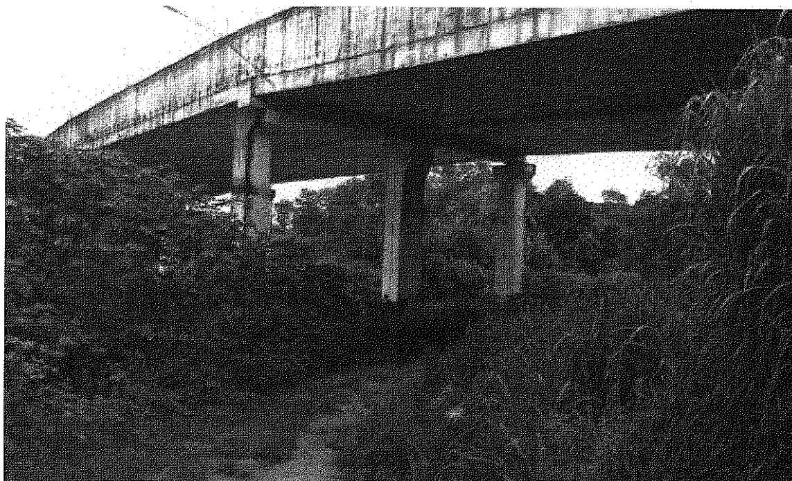
Foto I-4: Vista da estrutura por baixo
