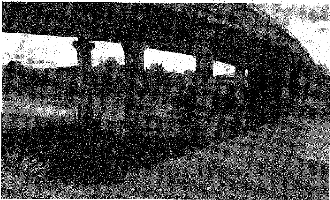
Foto II-4: Vista por baixo da travessia com as margens
