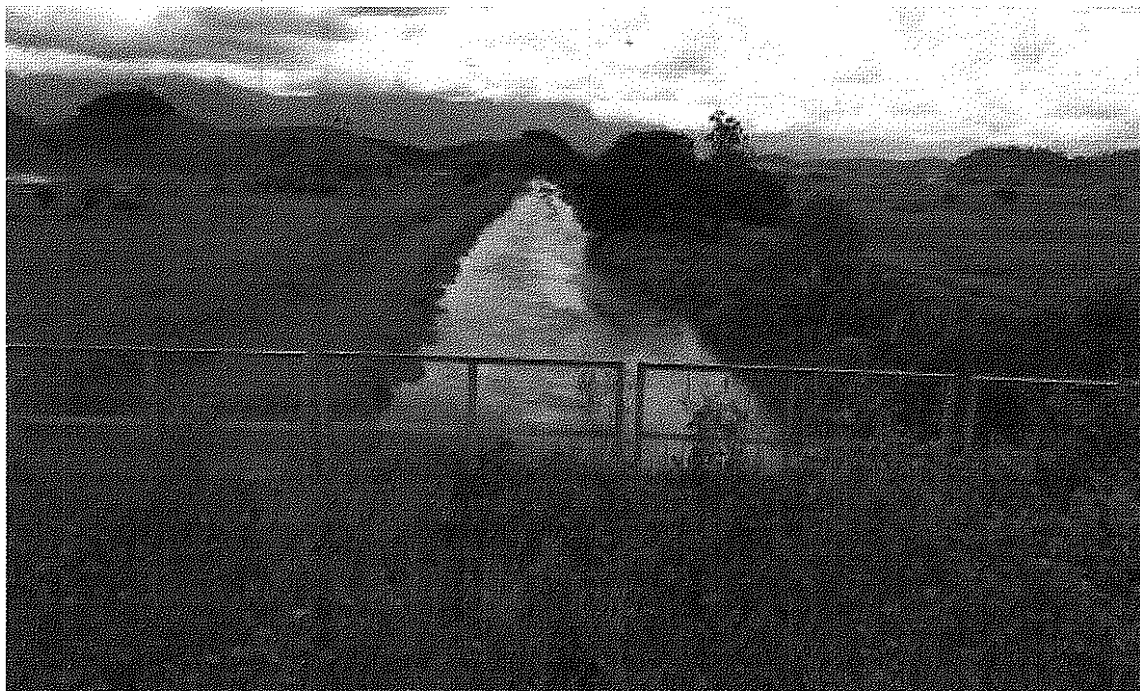
Foto II-5: Margens à montante
