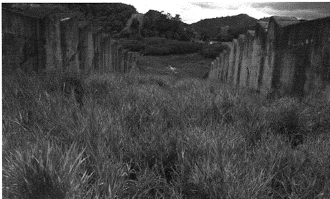
Foto IV-7: Parte de cima da estrutura
