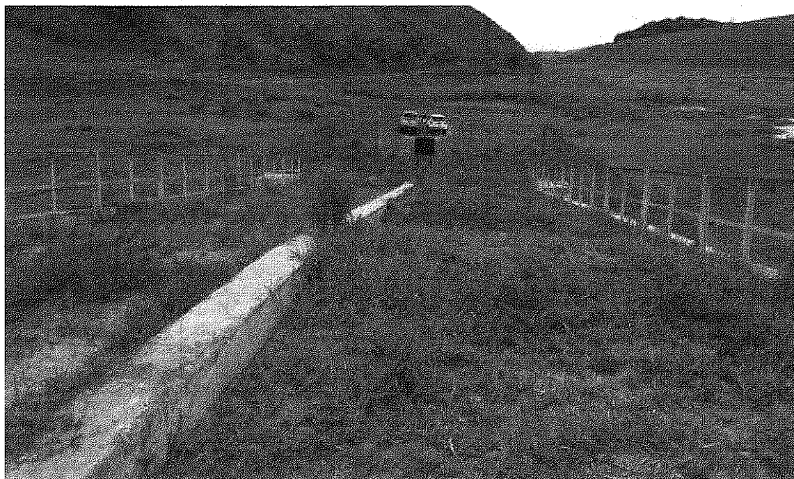
Foto III-6: Vista por cima da estrutura
