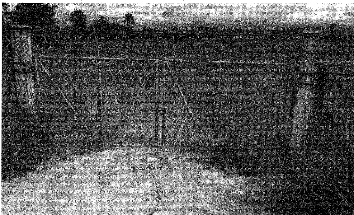
Foto I-2: Portão de acesso 2
