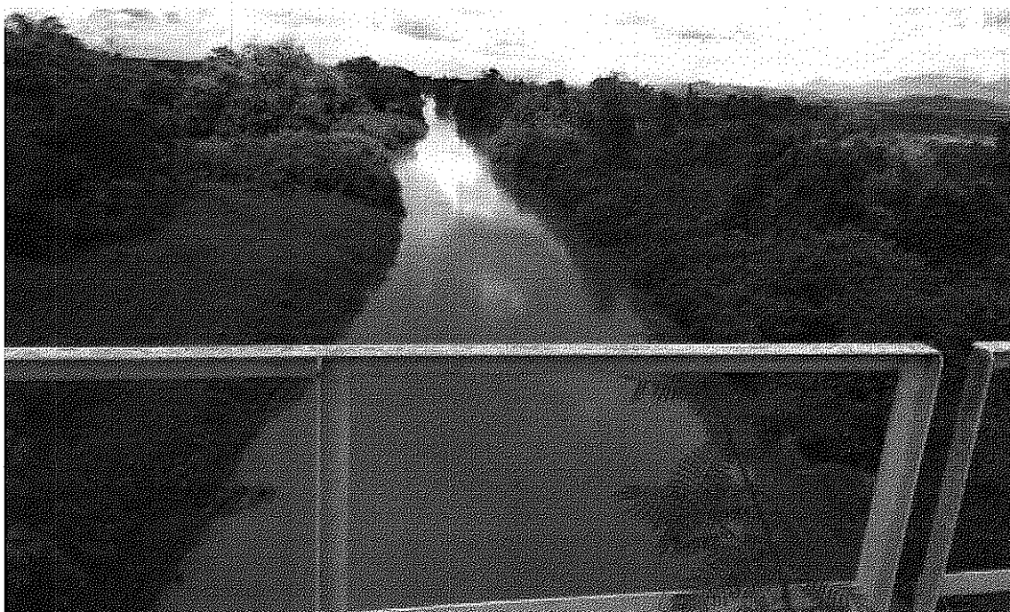
Foto I-6: Margens à jusante
