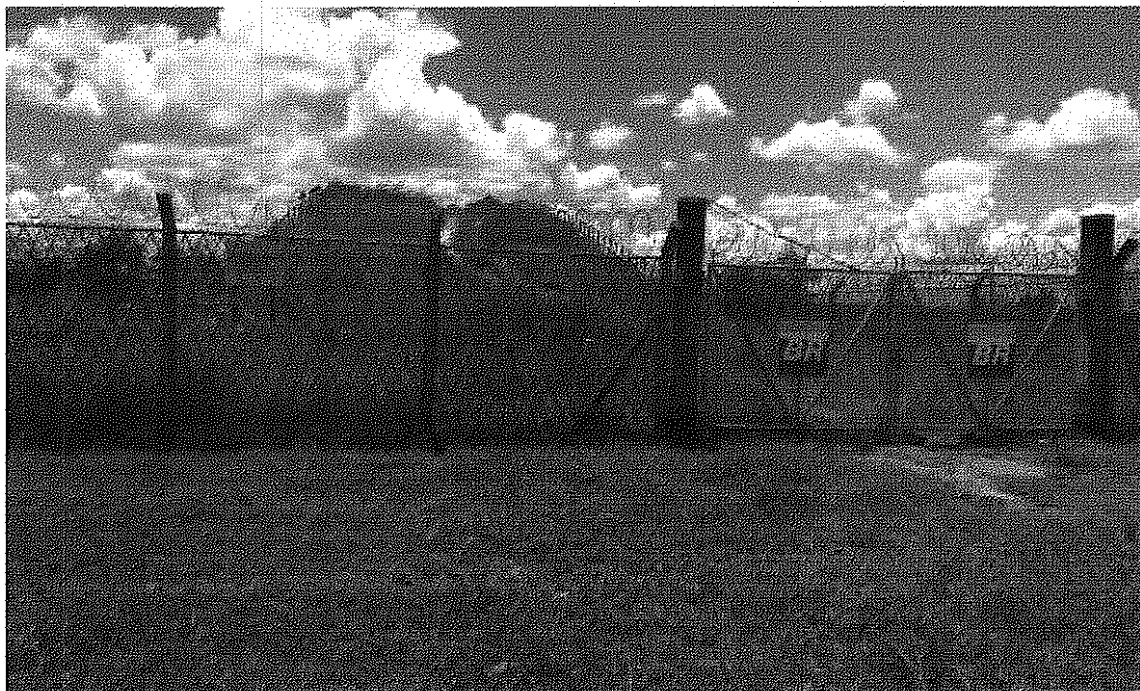
Foto II-1: Portão de acesso 1
