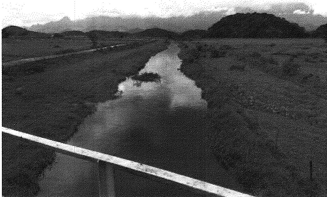
Foto III-5: Margens à jusante
