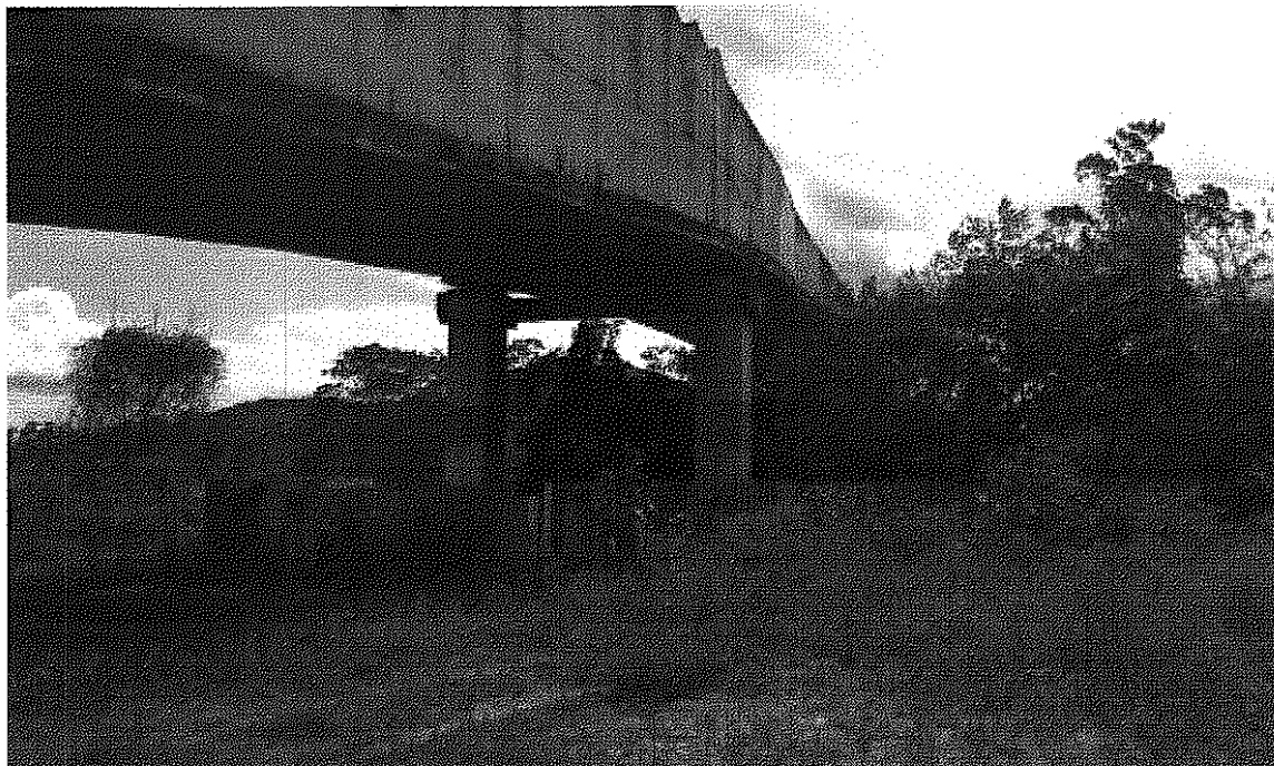
Foto IV-3: Vista lateral da estrutura
