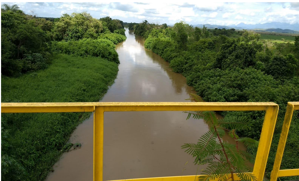
Foto I-6: Margens à jusante
