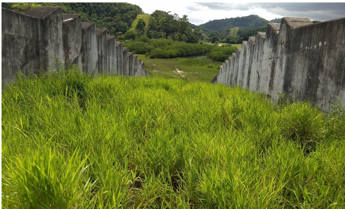
Foto IV-7: Parte de cima da estrutura
