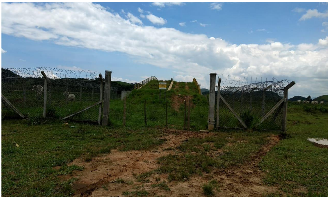
Foto III-1: Acesso – sem portão, com cerca
