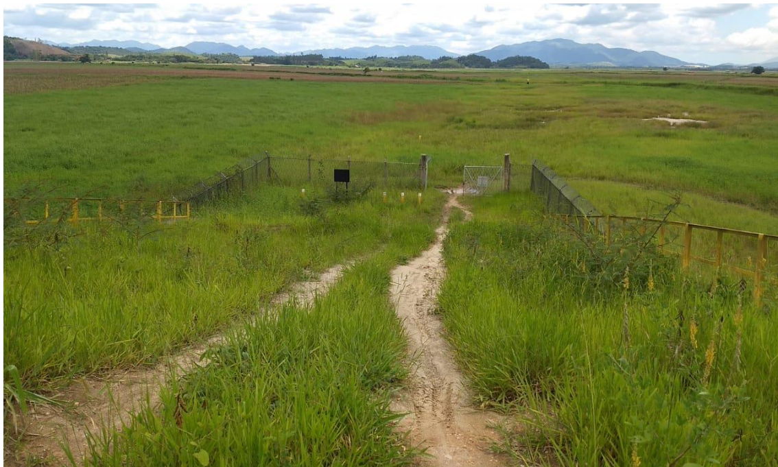
Foto II-7: Parte de cima da travessia
