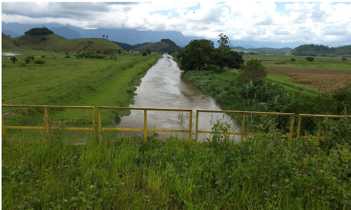
Foto II-5: Margens à montante
