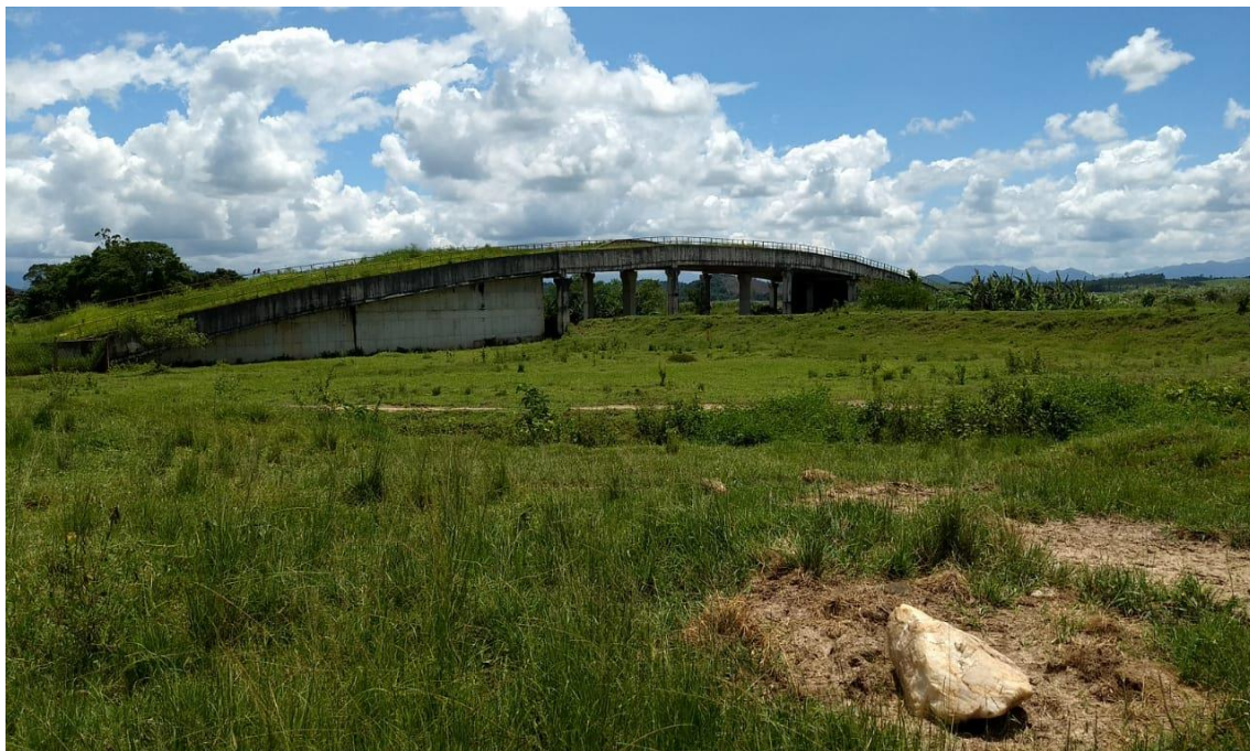
Foto II-3: Vista lateral da travessia
