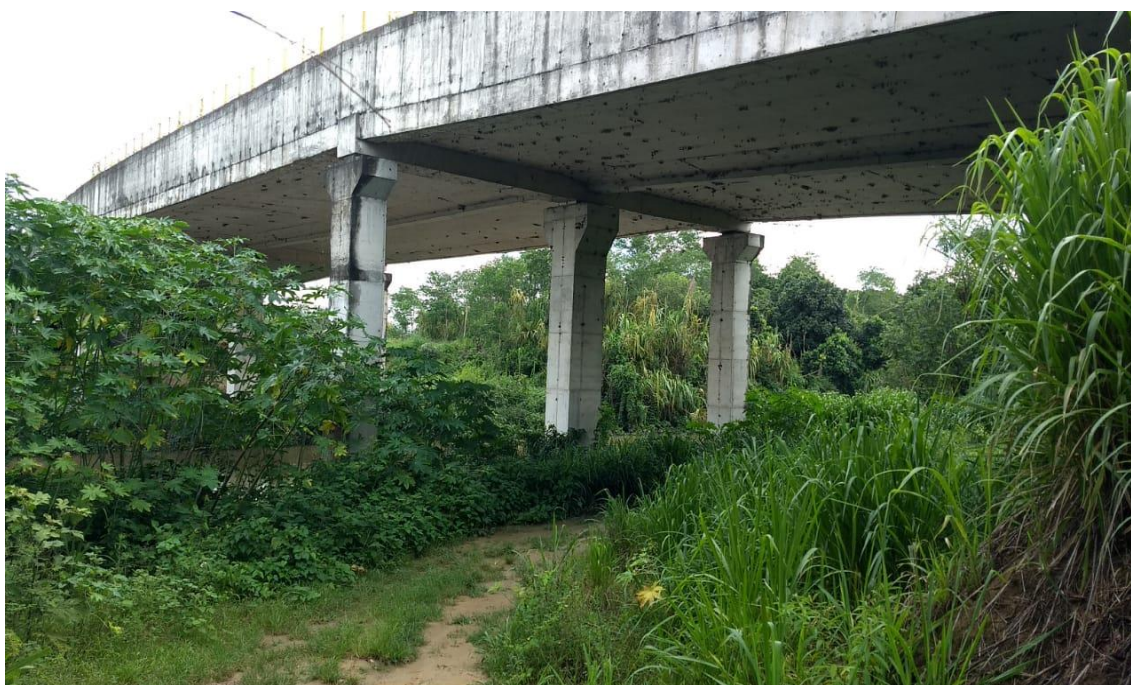
Foto I-4: Vista da estrutura por baixo
