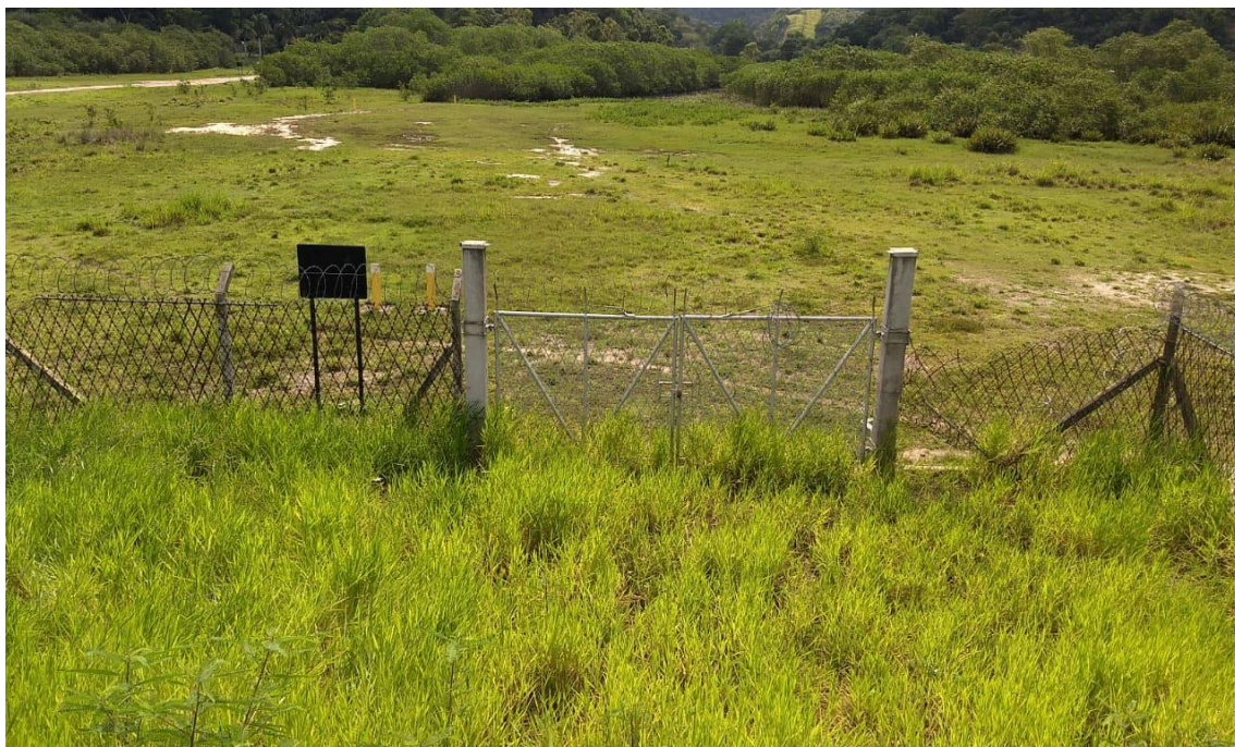
Foto IV-2: Portão de acesso 2
