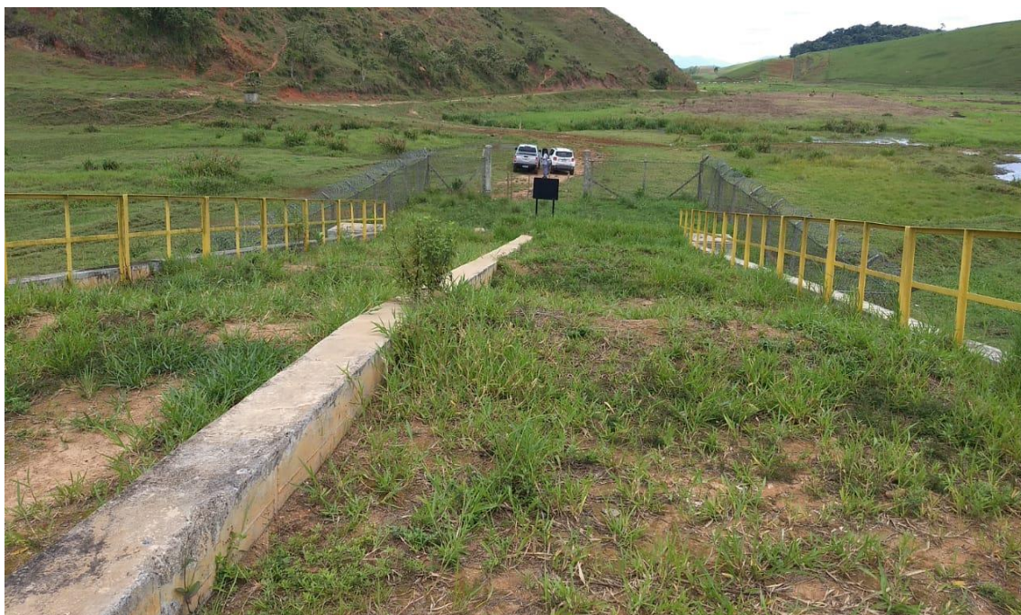
Foto III-6: Vista por cima da estrutura
