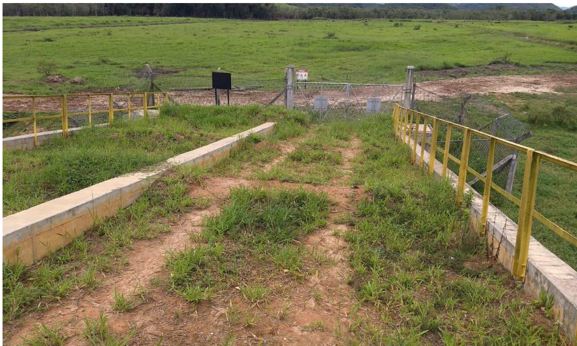
Foto III-7: Vista por cima da estrutura
