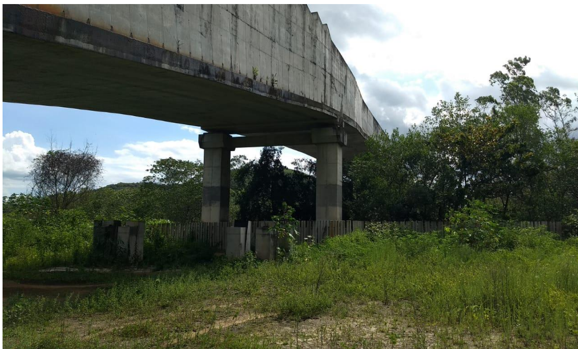
Foto IV-3: Vista lateral da estrutura
