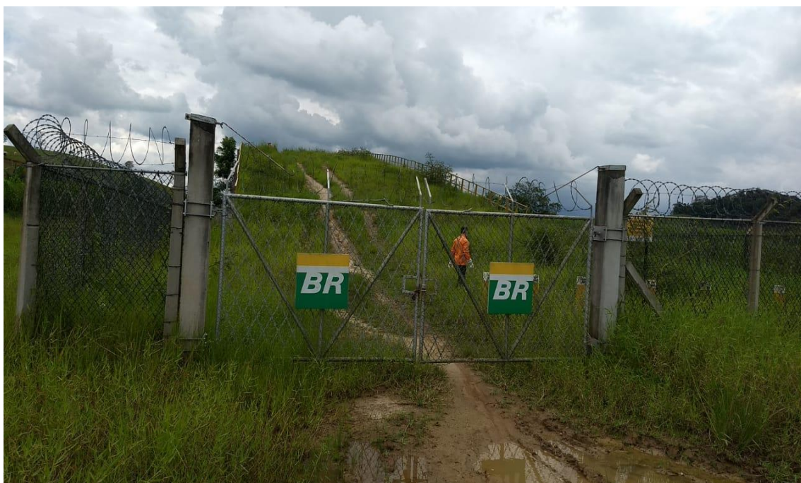
Foto II-2: Portão de acesso 2
