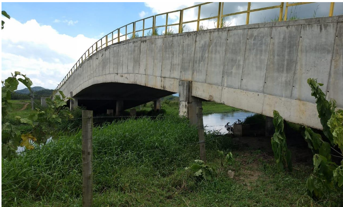
Foto III-3: Vista lateral da estrutura
