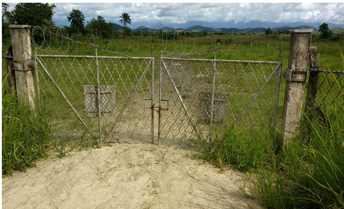
Foto I-2: Portão de acesso 2
