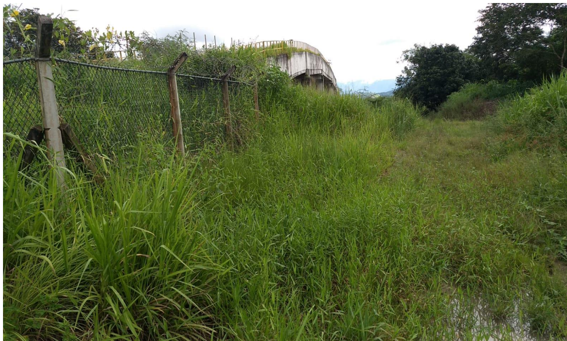
Foto I-3: Vista lateral da travessia
