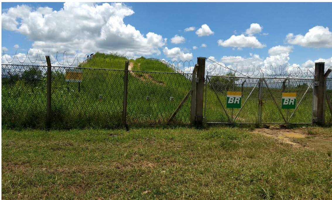
Foto II-1: Portão de acesso 1
