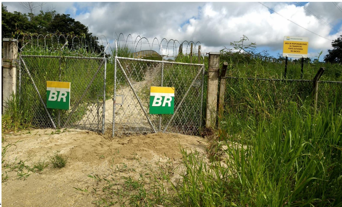
Foto I-1: Portão de acesso 1
